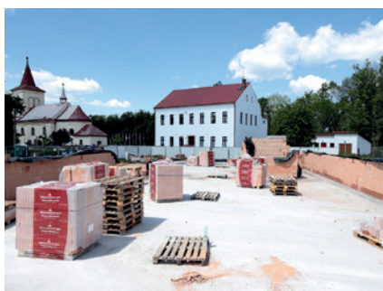
Pohled na základovou desku depozitáře v Robousích.
