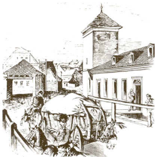
U vodárenské věže na hrázi rybníka
