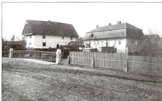
Jičín - dům „Na Kocourku“ Originál uložen v archivu RMaG Jičín
