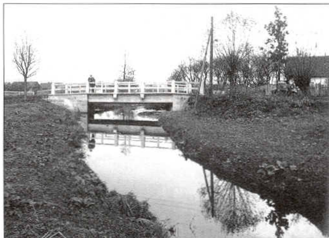
Jeden ze tří železobetonových mostů z 20. - 30. let 20. století Foto: Archiv Městského muzea v Hořicích
