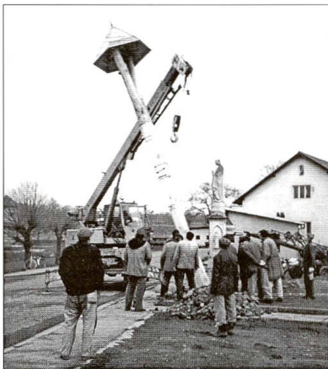
Stavba nové zvonice v roce 1994
