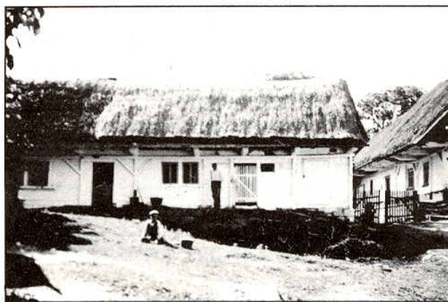
Stavení č. 4 a 5 (bývalá hospoda) Foto K. Řezníček, Kbelnice 1935
