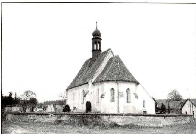
Kostel se hřbitovem
