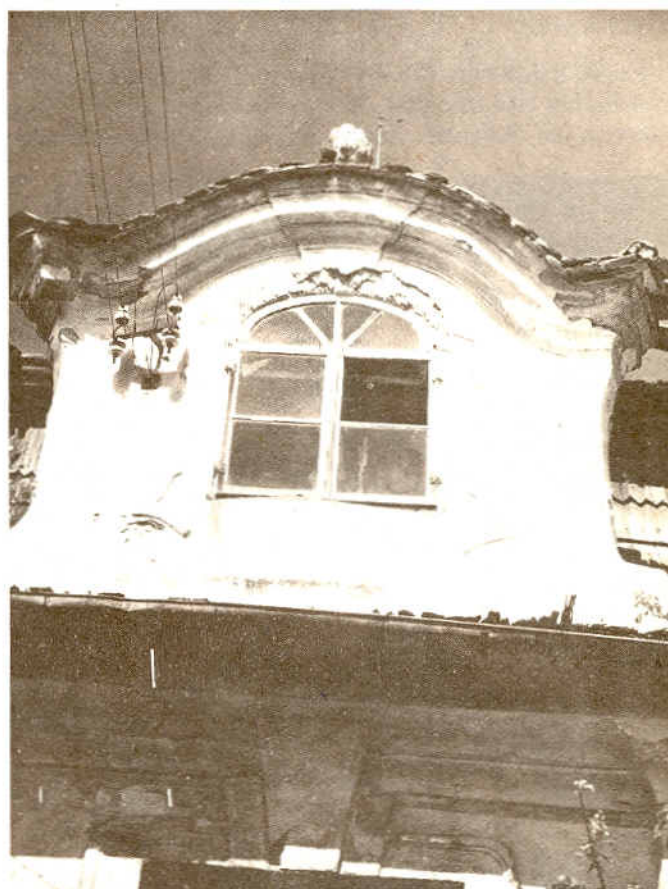
Detail okna mansardové střechy radimské fary
